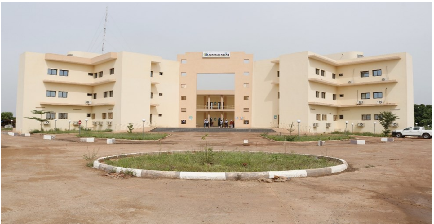
Image : Bureau de l'Agence Nationale de Gestion des Stations d'Épuration du Mali à Sotuba.
